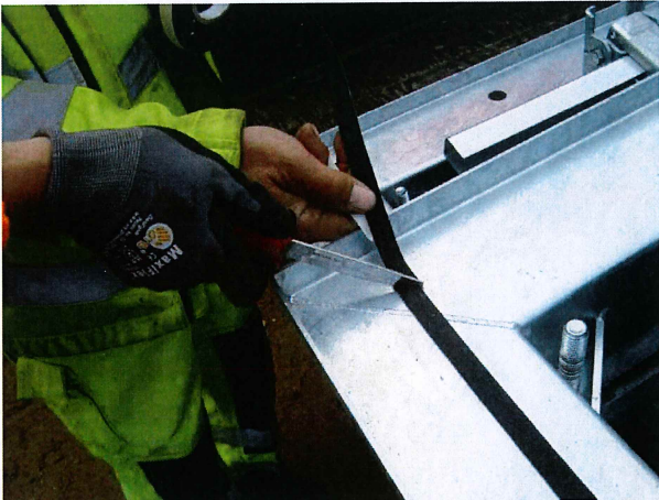
7) Skjær pakningsbåndet i 45° skråkant i hjørnene.
