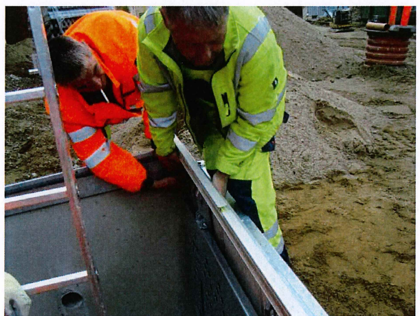
17) Juster rammen i vater med hjelp av justerings-skrueene som er i alle 4 hjørner. Justeringsskrueene kan skrues med fingrene! Det er mulig å finjustere rammen, etter at belegningen er lagt, samt å etterjustere rammen på et senere tidspunkt – når belegget med tiden eventuelt har satt seg litt.
