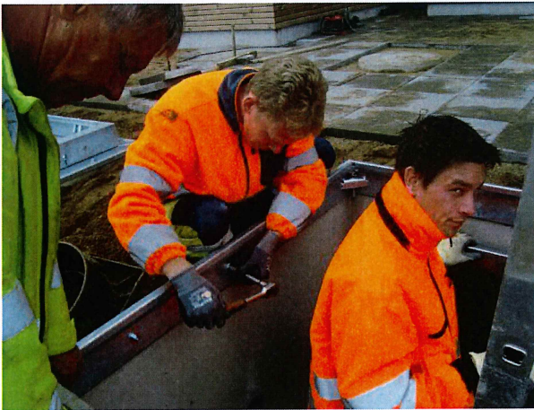
19) Når rammen er justert i vater med ønsket terrenghøyde, skrus den sammen. Bruk en 17 mm pipenøkkel (skru ikke for hardt).
