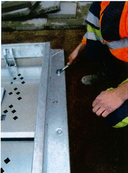
13) Skru rammen fast til brønnen med 12 stk. M12 x 30 mm bolter + skiver med en 19 mm pipenøkkel.
