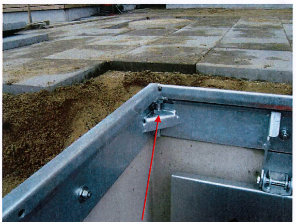
18) Justeringsskrue OBS: Det er viktig at betongbrønnen graves ned i korrekt dybde! Rammen kan max. justeres 38 mm opp!
