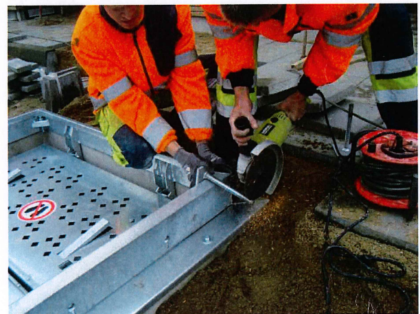
23) Det kan forekomme, at støtteføttenes gevindstenger er for lange. Skulle det være tilfelle må de kuttes med en vinkelsliper.
