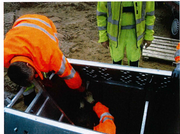
24) Når høyden på støtteføttene er justert, monteres gassfjærene fast til hengselarmene igjen.
