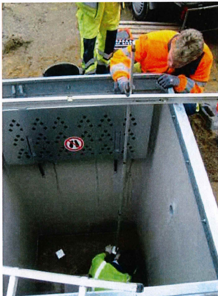
21) Høyden på støtteføttene justeres ved å skru dem ned/opp i de innstøpte innsatsene.
