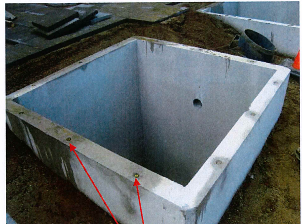
10) Fjern plastikkproppene som beskytter de innstøpte festene. Bruk f.eks. en skrutrekker.
