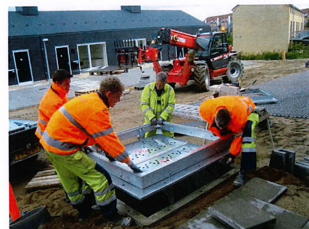
12) Løft sikkerhetssystemet på plass over betongbrønnen. Bruk evt. en 4-punkts løftesele og en maskin til å løfte sikkerhetssystemet på plass.
