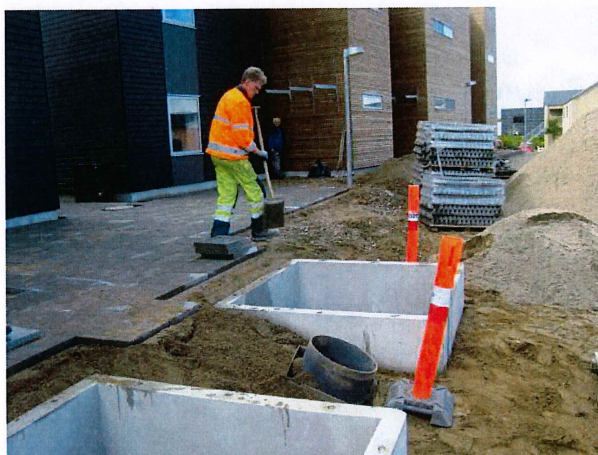
9) Gjør det rent rundt betongbrønnen før sikkerhetssystemet skal monteres på dens overkant. Overkanten av brønnen skal feies helt ren for sand og lignende. Det gjør ikke noe at overkanten er fuktig, det ekspanderende fugebåndet skal sørge for at det blir tett mellom brønnens overkant og rammens underkant.
