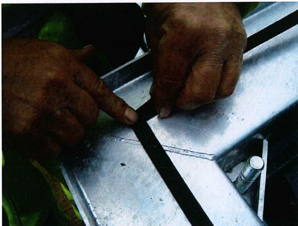
8) Trykk pakningsbåndet fast med fingrene
